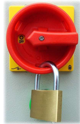
Abb. 86 Hauptschalter gesichert
