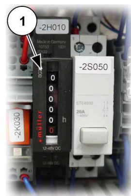
Abb. 92: Betriebsstundenzähler
