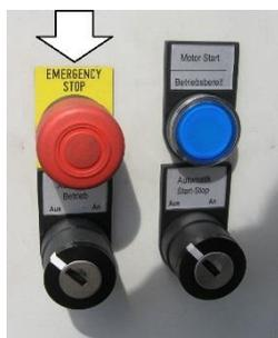
Abb. 15 a: NOT-AUS-Schalter (Pfeil) am Schaltkasten
