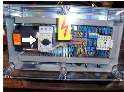
Abb. 49: Kontrollleuchte Spannung
