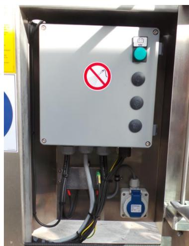
Abb. 5-12 Steuerschrank in der Arbeitsbühne
